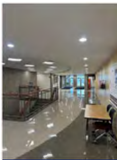
Non ACM 12x12 Floor Tile
