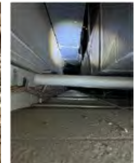
Above Ceiling Non ACM Pipes
