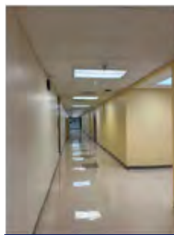
Non ACM Ceiling Tiles
