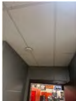
Non ACM Ceiling Tiles
