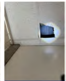
Above Ceiling Non ACM
